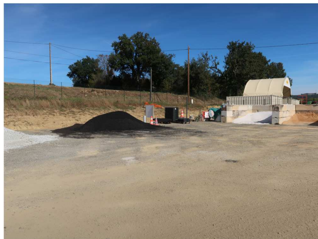
Talus en bordure de plateforme
