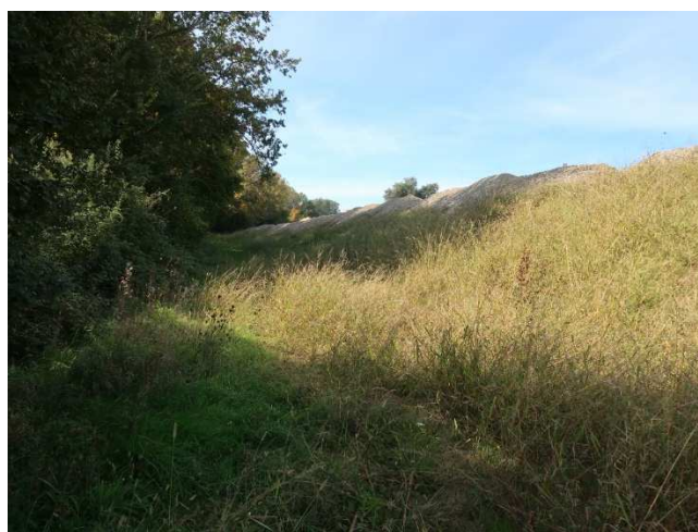
Talus en bordure de plateforme
