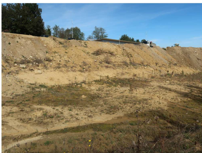
Talus en bordure de plateforme (remblaiement à l'aide de matériaux inertes)
