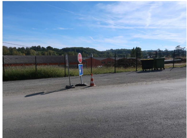
Aménagement de l'entrée du site
